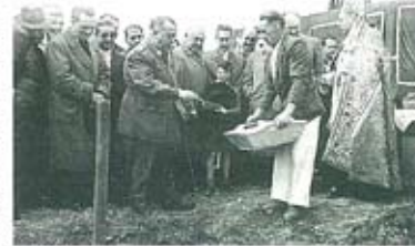
Colocación de la primera piedra del barrio. ■ SANTIAGO ARINA
